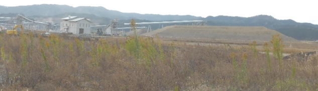
陸前高田の大規模な盛土工事
